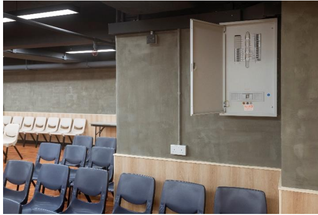
更換電箱及翻新牆身
