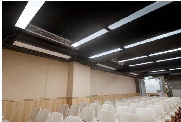
更換 3 套冷風機連風槽及全場照明
